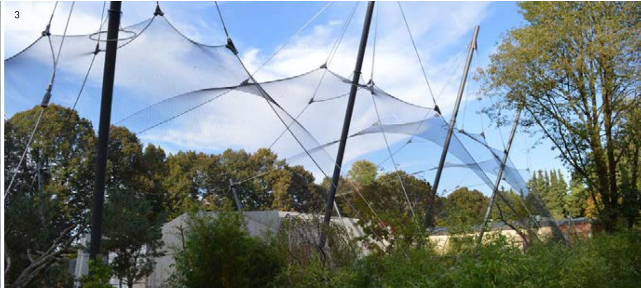
Begehbare Voliere für Watvögel mit außenliegender Zugseil-Konstruktion
