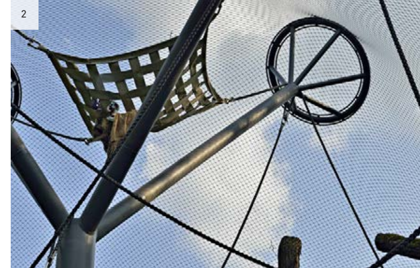
Pylon-Verzweigung für Gehege-Gestaltung und Last-Verteilung Pylon with branches for enclosure design and for load distribution
