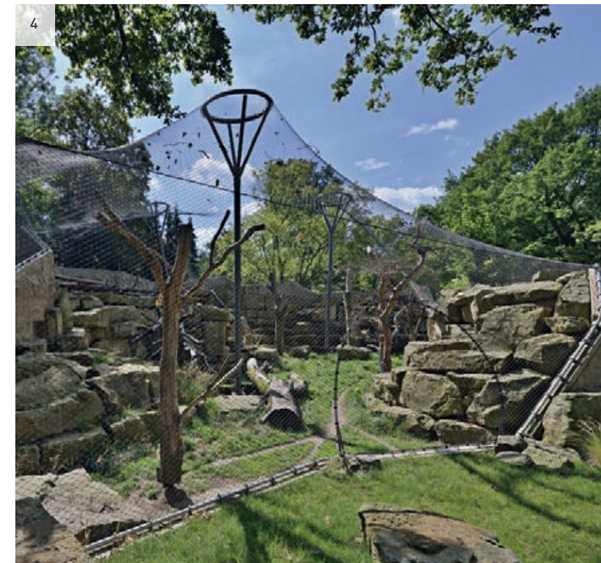
Revisionsöffnung im Wandnetz für Gehegepflege Inspection entrance in the wall mesh for the enclosure's maintenance
